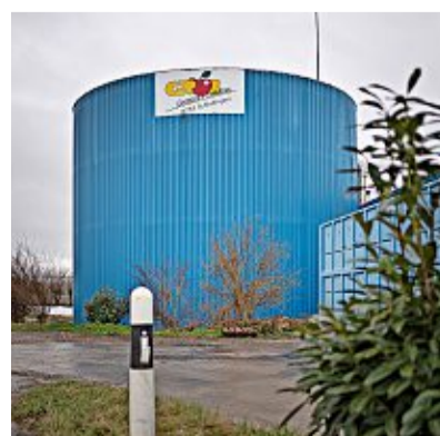
Das warme Wasser aus der Tiefe wird in diesem Tank gesammelt.
